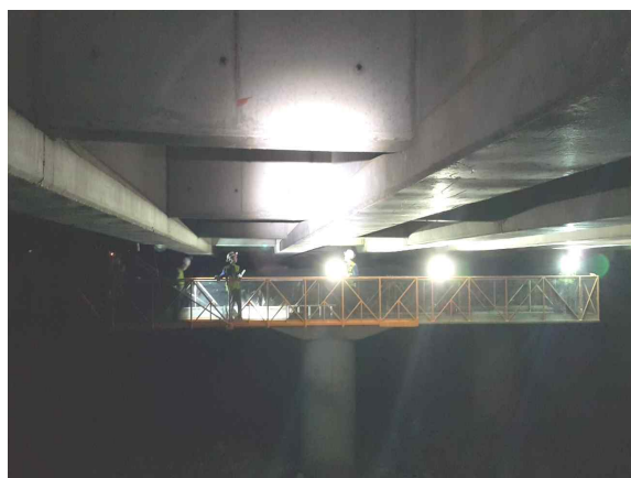
교량점검차를 이용한 외관조사 전경①
