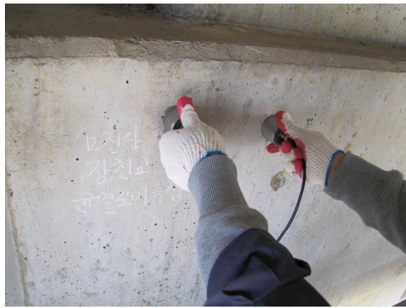
초음파(Pundit)를 이용한 균열깊이 측정 전경
