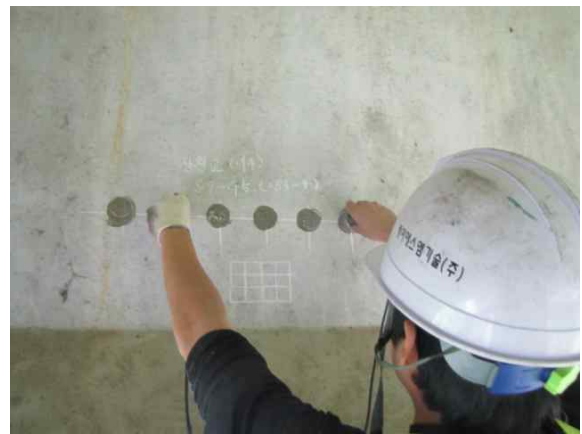
초음파전달속도 시험 전경
