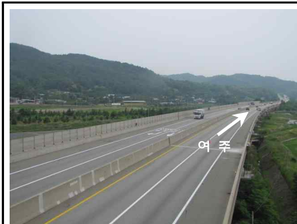
교량 상부 전경
