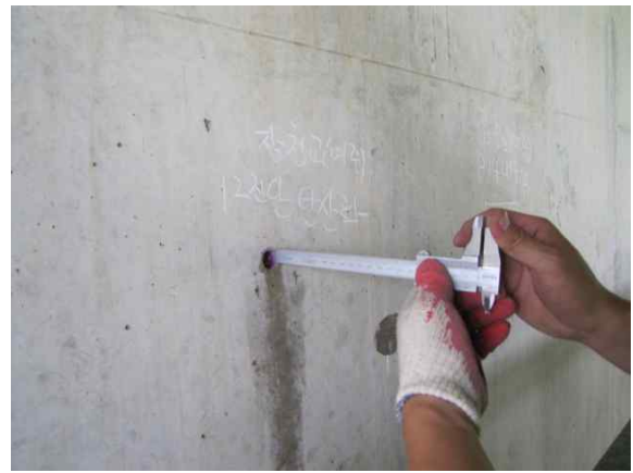
페놀프탈레인용액을 이용한 탄산화 깊이 측정 전경
