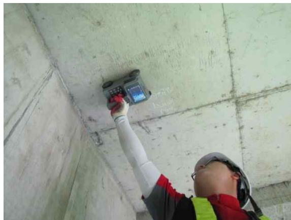
Rc-Radar를 이용한 철근배근 및 피복두께 측정
