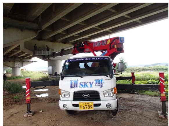
고소점검차를 이용한 외관조사 전경
