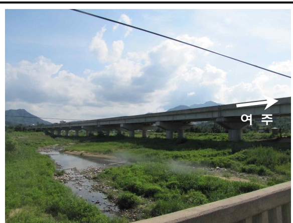
교량 측면 전경
