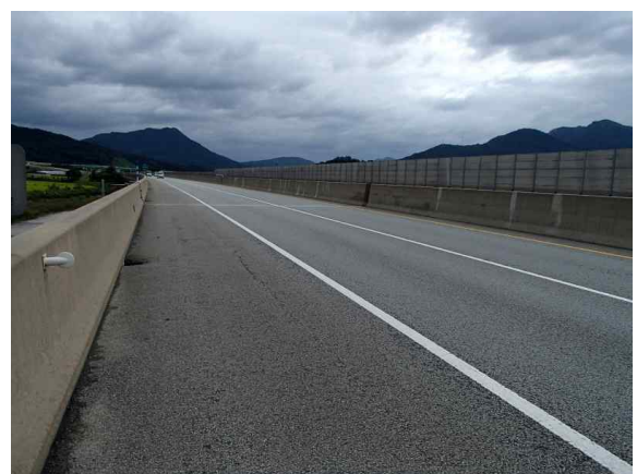
교면 포장 상태 전경
